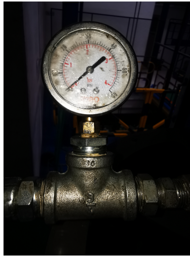
Figura 23: TEE hidráulica con Manómetro 0-60psi
