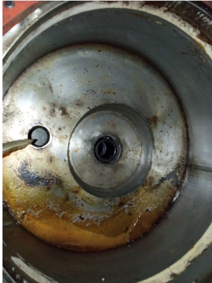
Figura 44: Concentricidad de tazón de lodos y unidades de rodamiento
