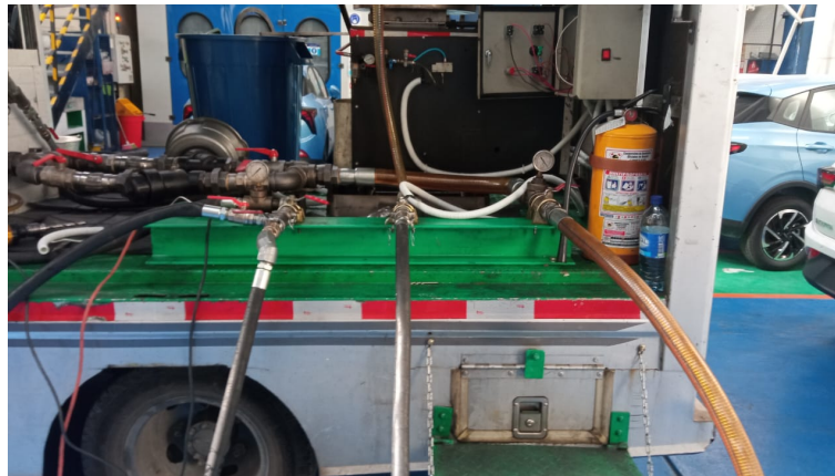
Figura 30: Montaje de mangueras
