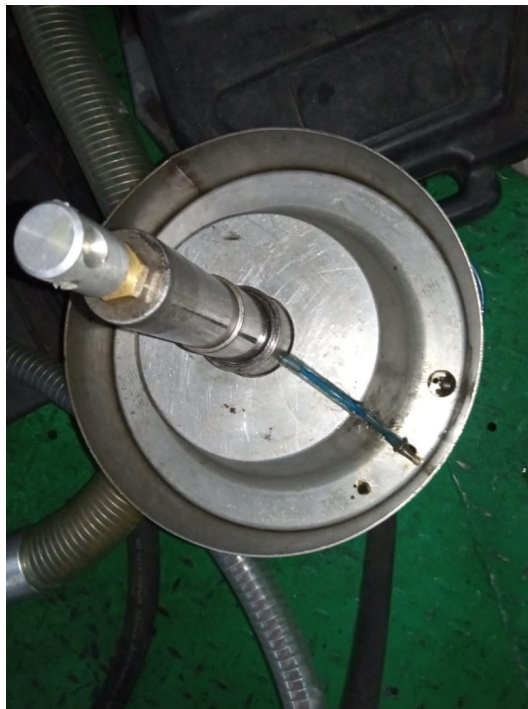
Figura 56: Montaje de línea neumática
