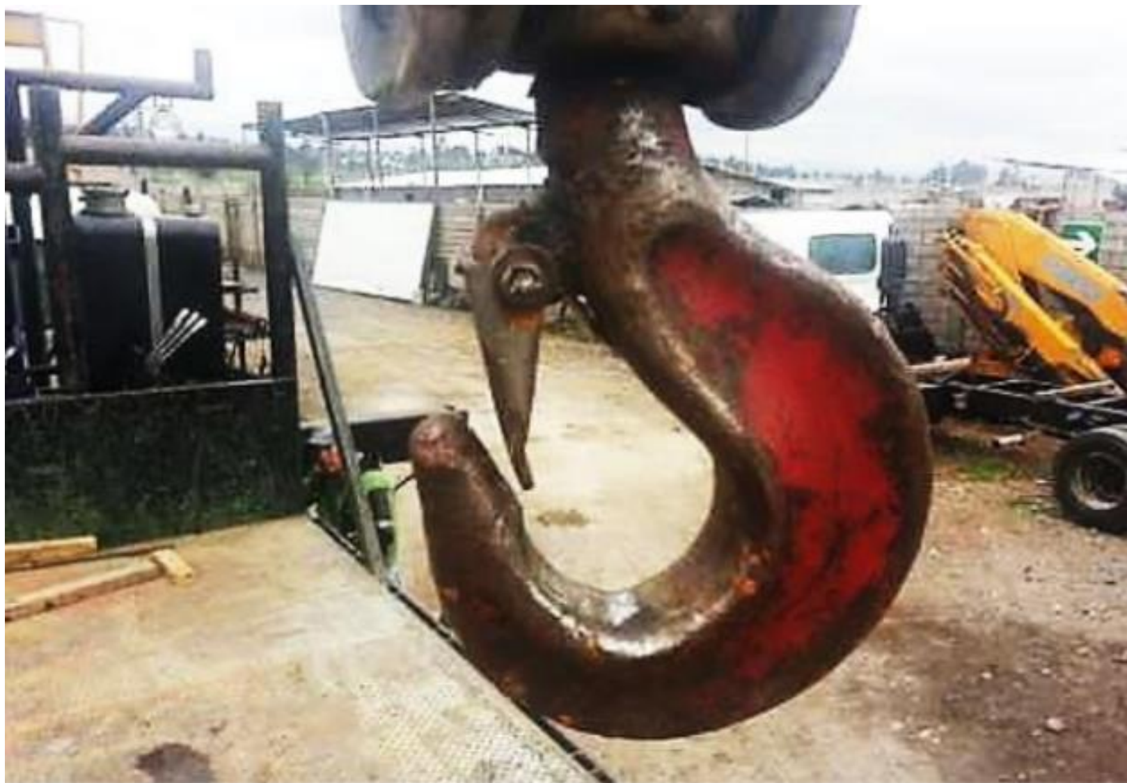
Condición insegura – Ganchos de izaje defectuosos
