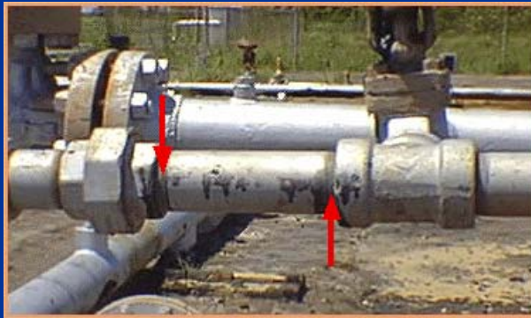
Uniones de Tubería
