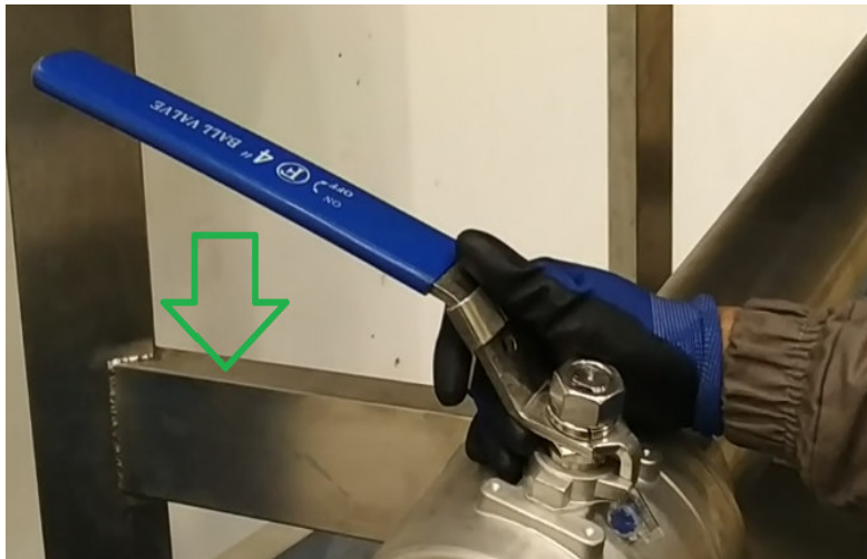
Figura 8. Apertura de registro
